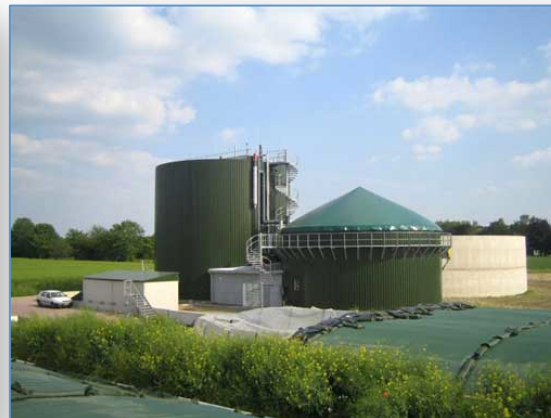
Planta de producción de biogás (metano)
